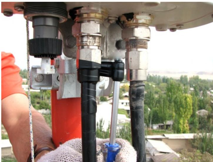
1. Подготовьте кабель, удалив маркировку и протерев кабель и соединения.
