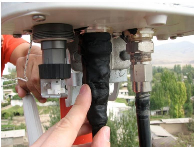
1. Распределите толщину ленты, растягивая ее таким образом, что она обернет полностью коннектор и кабель. Заверните пленку вокруг коннектора и кабеля. Сожмите края ленты, чтобы не было зазоров.
